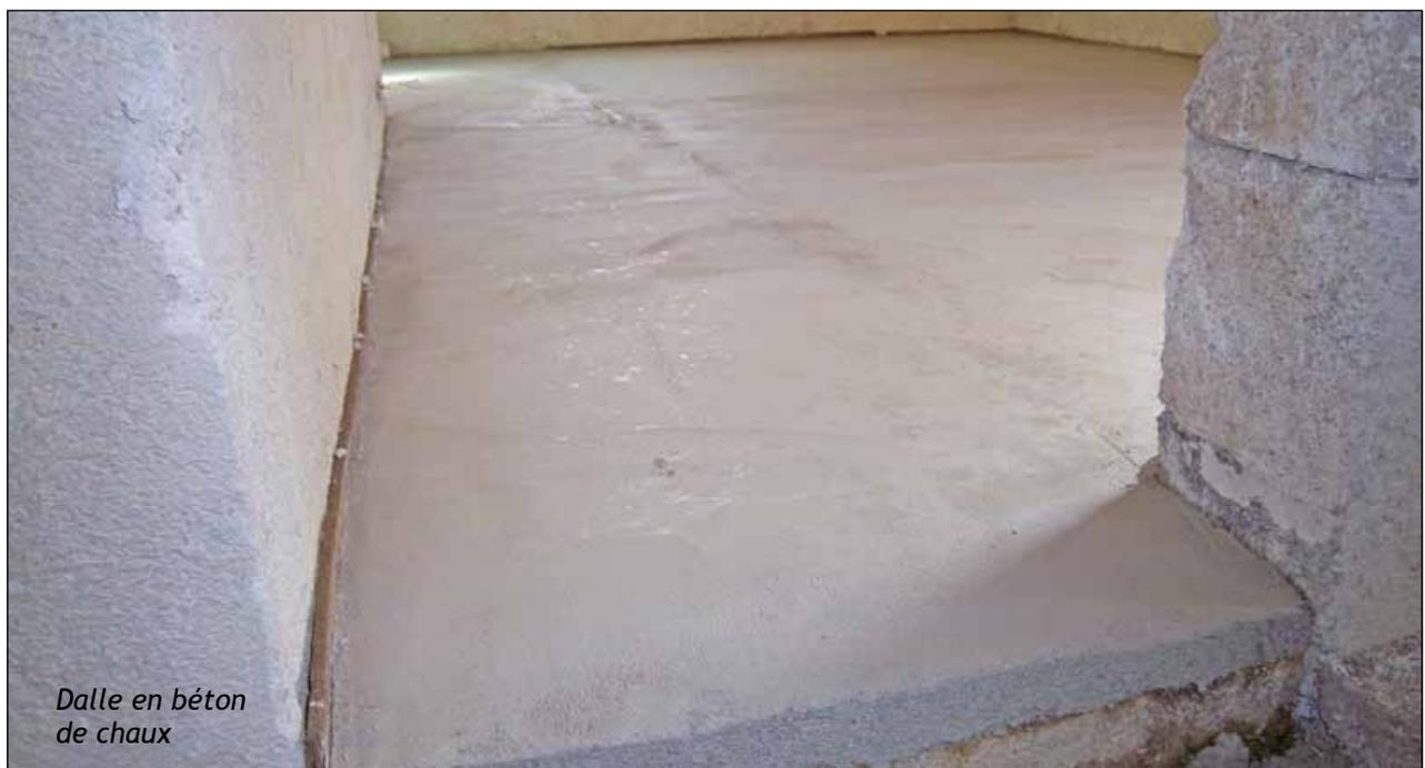
Dalle en béton de chaux
